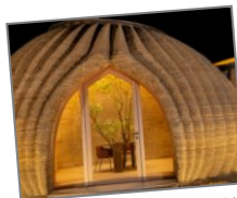
Maison Tecla en terre crue imprimée.
